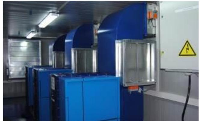
Предусмотрена вся обвязка трубопроводами, вентиляция оборудования в зависимости от требований завода изготовителя, кабельная разводка собственных нужд модуля в «кабель-каналах», силовые кабели для питания компрессоров освещение, отопление, аварийная пожарная сигнализация;
